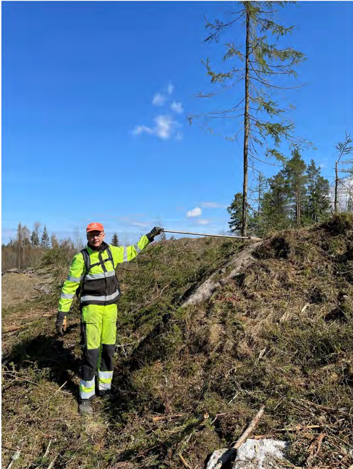
Figur 21. Fjellknausene av større størrelse må sprenges bort for å kunne få et jordbruksareal med god arrondering. Bilde viser hvor mye som må sprenges bort for å jevne ut terrenget (fra jordboret ned til hvor Trond K. Haraldsen står) (Foto: Monica Jayesingha).
