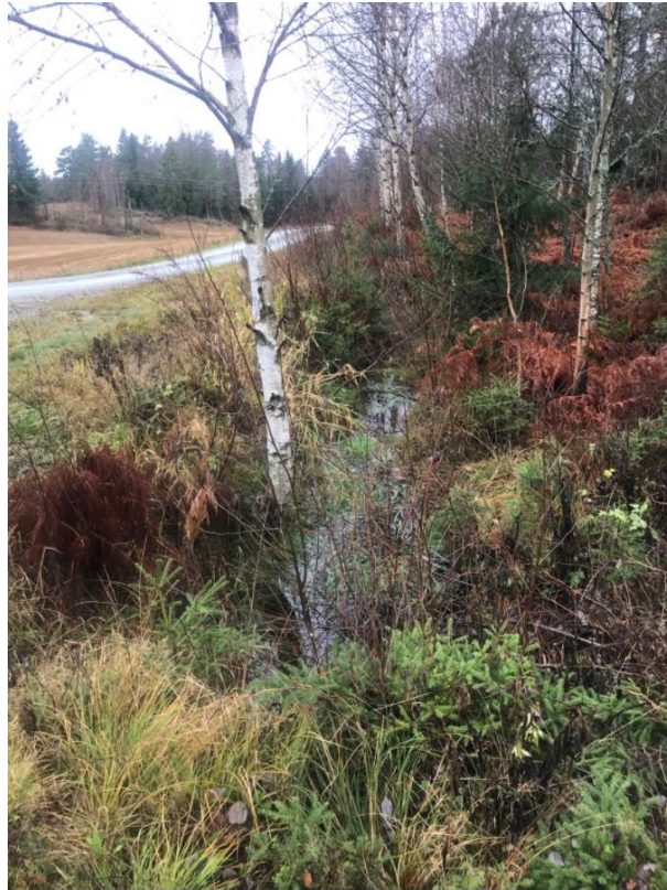
Figur 8 Situasjonfoto, A3 syd for vei langs samme dreneringsgrøft.
