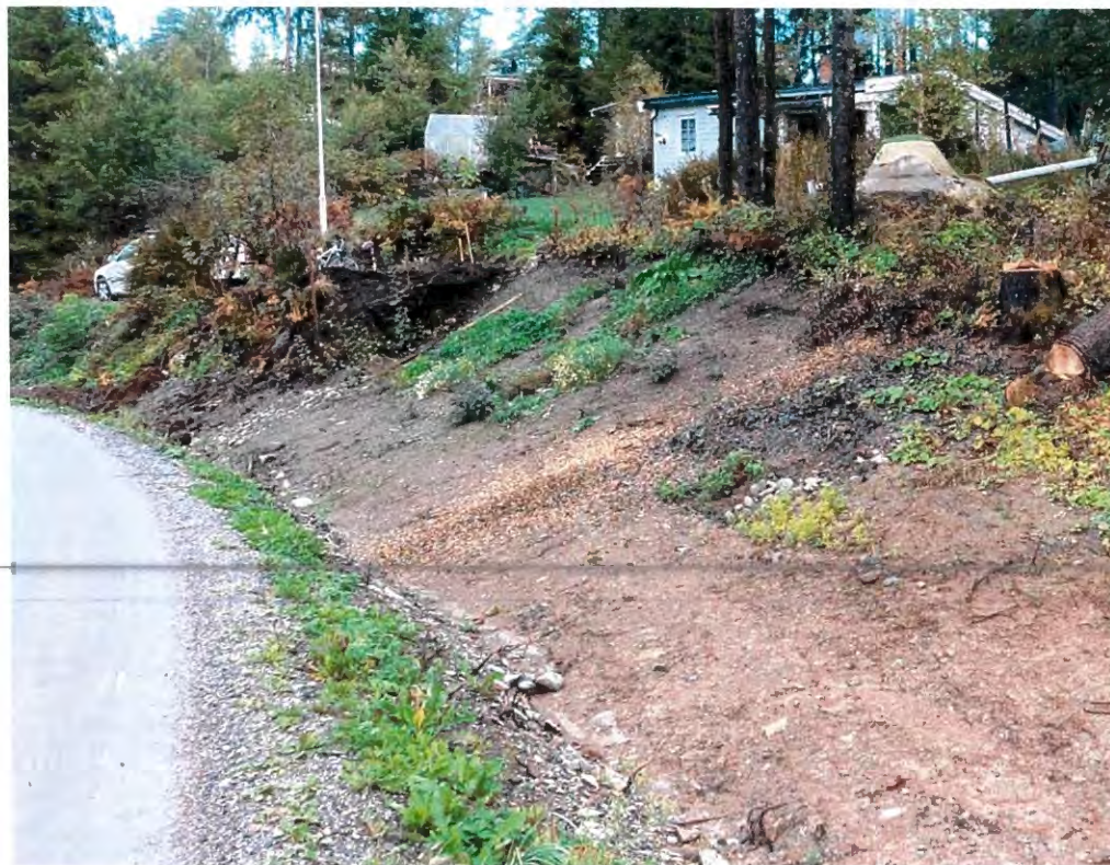
Bilde av et uløvlig avløps anlegg oppe i høyre hjørne av bilde
