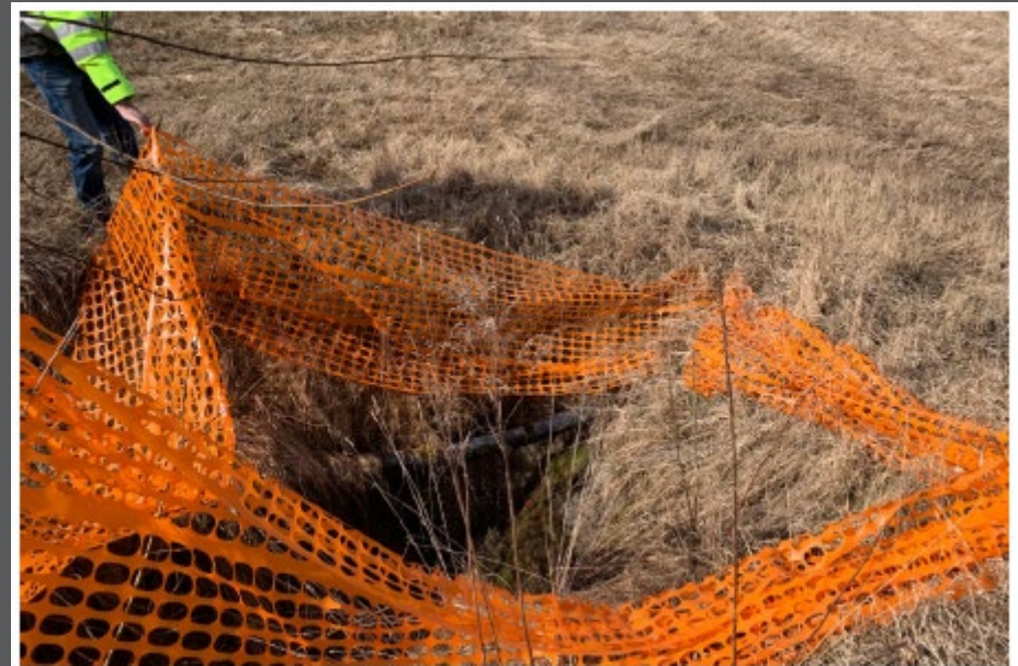
Bilde 6: Punkt 60. Den største erosjonsskaden på jordet ved Knapstad.
