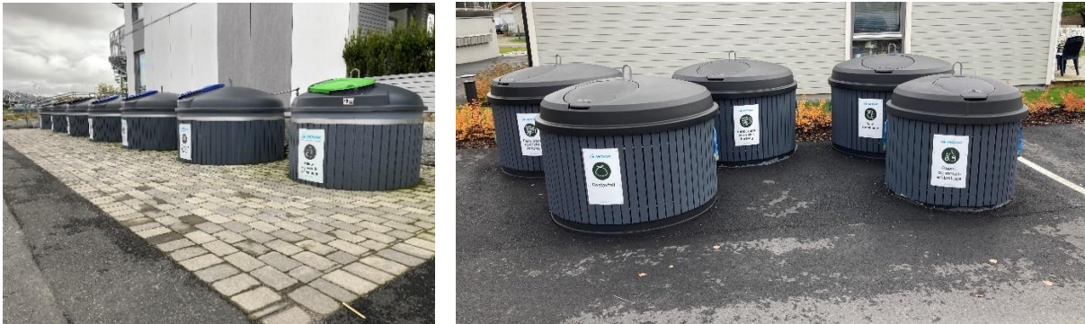
Figur 5.2: Delvis nedgravde oppsamlingsenheter
