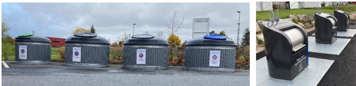
Figur 5.1: Delvis nedgravde oppsamlingsenheter (t.v.) og helt nedgravde oppsamlingsenheter (t.h.).
